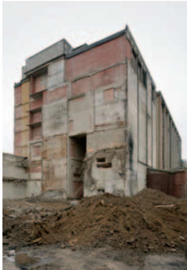
⤴ Belgoprocess stelt zich tot doel de afvalstoffen van de ontsmette gebouwen en installaties als niet-radioactieve grondstof te recyclen.
